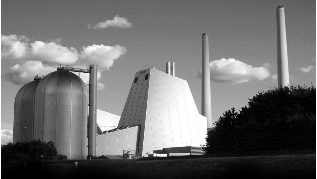
Слика 2.17. Данска ТО–ТЕ Avedøre 2 са два акумулатора топлоте
