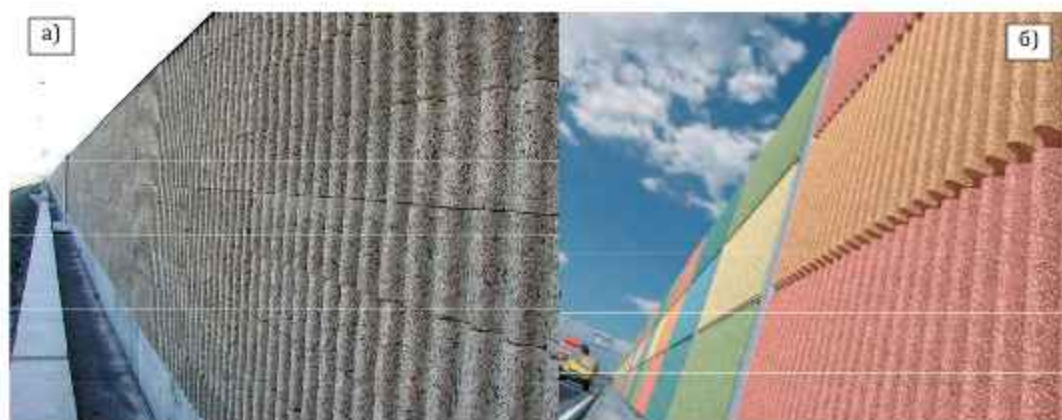
Слика 3.77. Примери звучних баријера од композитних материјала: а) дрвена влакна и бетон-произвођач CIR Ambiente [54], б) звучна баријера RUCONBAR од смеше бетона и рециклиране гуме [73],[75]
