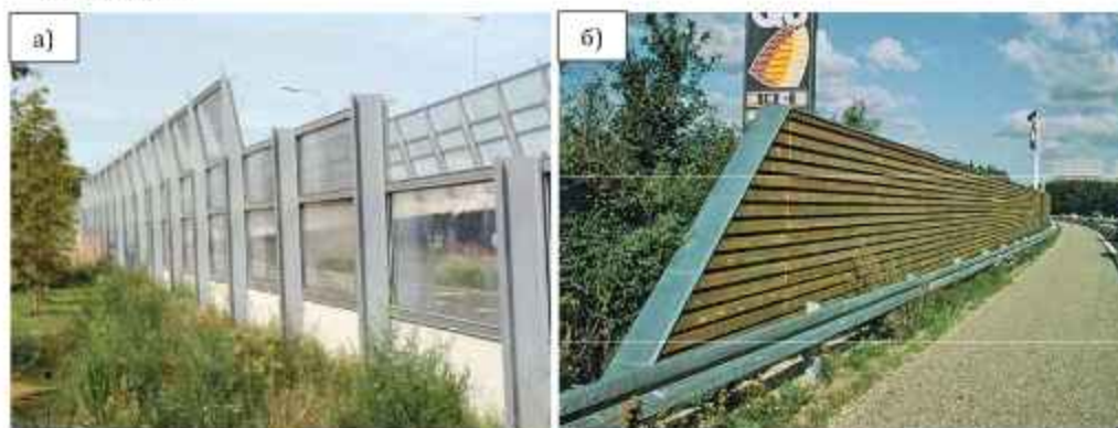
Слика 5.20. Пример постепеног завршетка баријере у три нивоа (а) и применом косог краја (б) [24]
