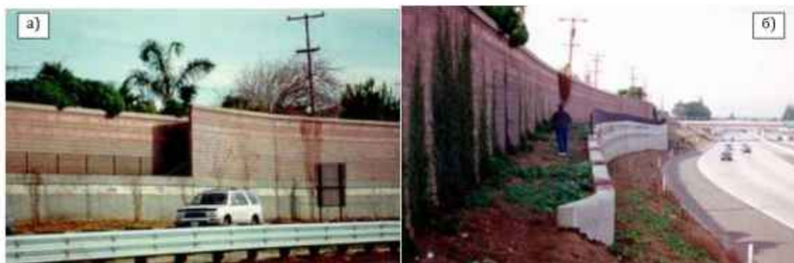
Слика 3.21. Примери постављања звучног зида: а) на потпорни зид и б) иза потпорног зида [25]
