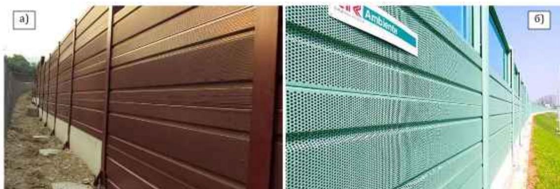
Слика 3.71. Примери металних баријера од: а) челика и б) алуминијума [54]
