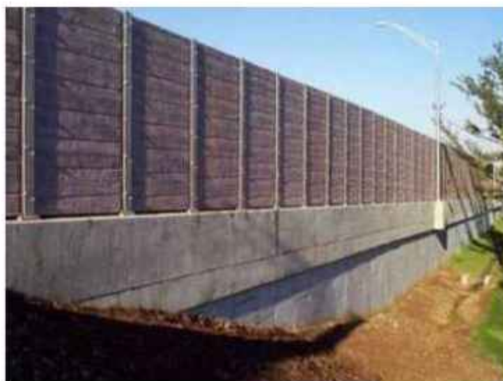
Слика 3.20. Пример звучног зида на потпорном зиду [25]
