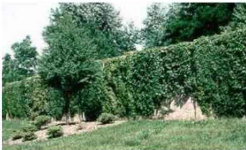
Слика 3.25. Пример комбинације звучног зида са вегетацијом [24]
