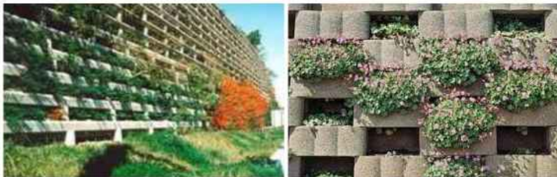
Слика 3.13. Самостојећи бетонски зидови са биљним засадима [25]
