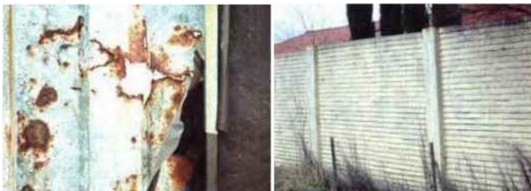
Слика 5.6. Оштећења од влаге и УВ зрачења [25]
