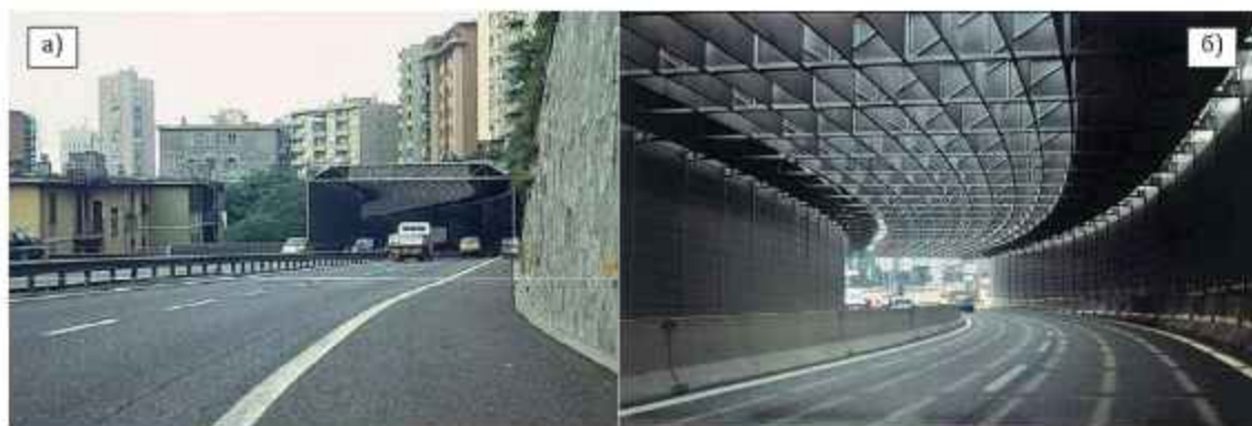
Слика 3.29. Пример тунелске баријере: а) прилаз и б) изглед изнутра [24]
