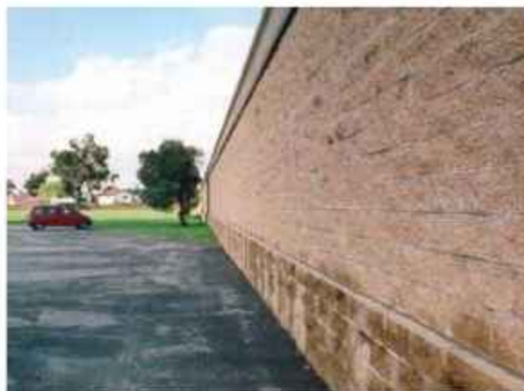
Слика 3.86. Баријера од зиданих блокова са поломљеним каменим рубовима [25]
