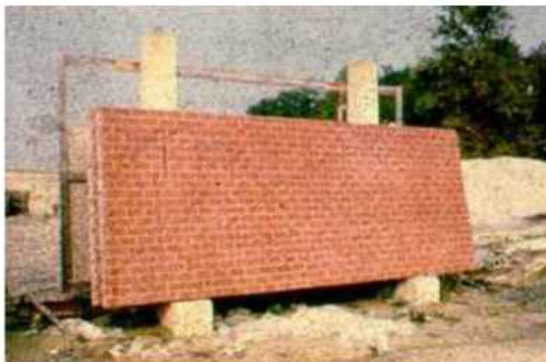
Слика 3.84. Текстура у виду цигле добијена утискивањем [25]
