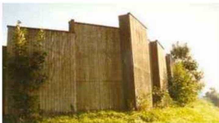
Слика 3.90. Ламинација – дрвене баријере [25]
