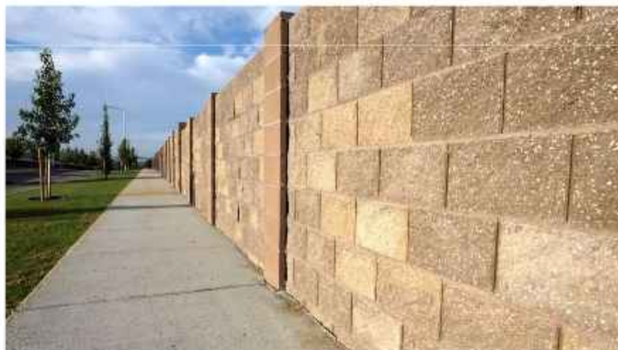
Слика 3.70. Пример звучне баријере од зиданих блокова [68]
