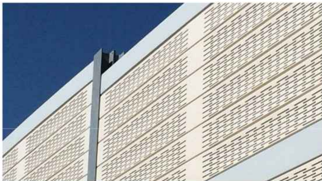
Слика 3.75. Примери апсорпционих пластичних баријера [72]
