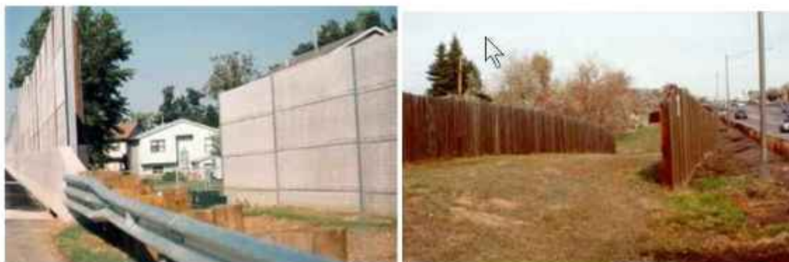
Слика 3.54. Отвори за хитне случајеве: преклапање баријера [25]
