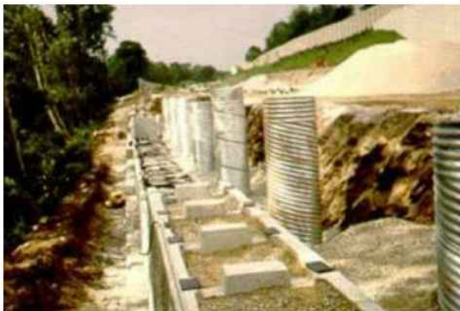
Слика 3.22. Примери звучног зида у комбинацији са или иза унапред произведеног потпорног зида [25]
