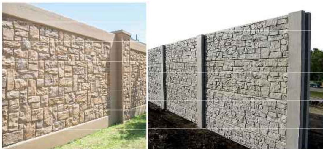
Слика 3.82. Текстура бетонске баријере добијена у калупу: а) [76], б) [67]
