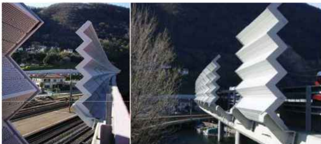
Слика 3.36. Пример степенастог „цик-цак“ зида [24]
