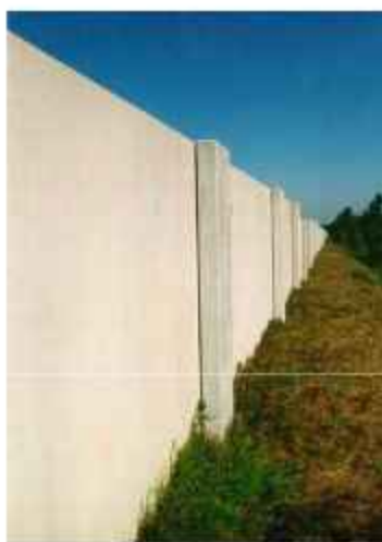
Слика 3.80. Бетонска баријера са глатком површином [25]
