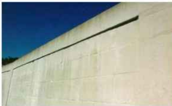
Слика 3.87. Stucco текстура на баријери од зиданих блокова [25]
