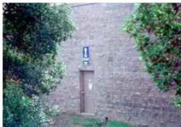
Слика 5.13. Пожарна сигурност: пожарна врата [25]
