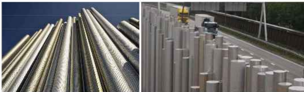
Слика 3.39. Пример специјалних цевних апсорбера [53]
