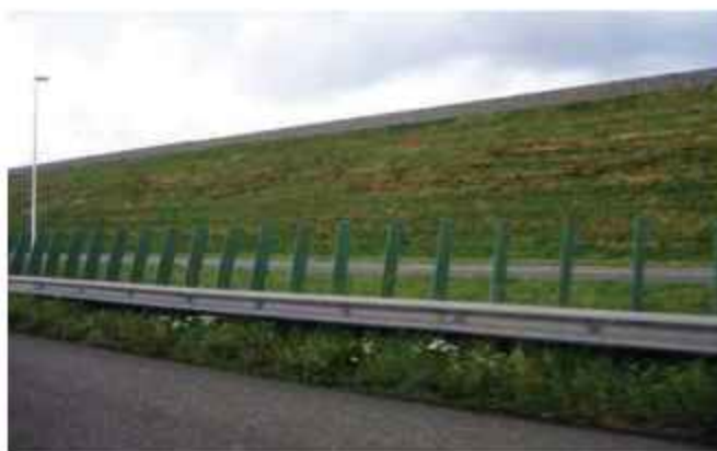
Слика 3.15. Земљана баријера са габионском баријером на врху [24]
