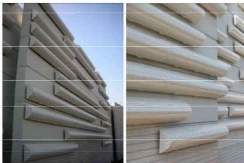
Слика 3.65. Полуцилиндрични акустички апсорбери са металним перфорираним оклопом [65]
