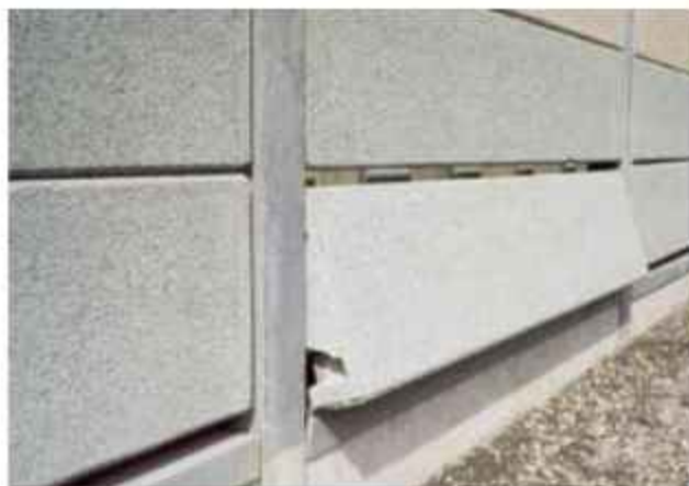
Слика 3.59. Покретни сегменти баријере за одвођење воде [25]
