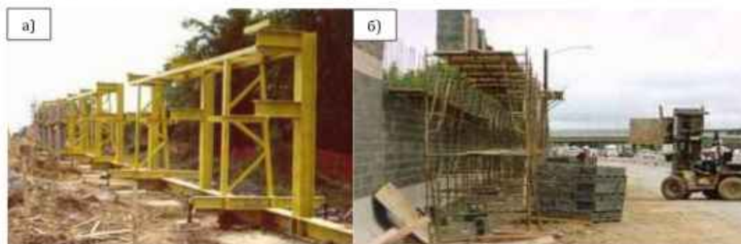
Слика 5.3. Помоћна опрема при монтажи: а) опрема за подршку, б) скеле [94]
