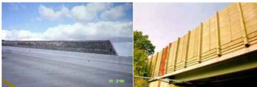
Слика 3.19. Примери звучних зидова на мостовима [25]
