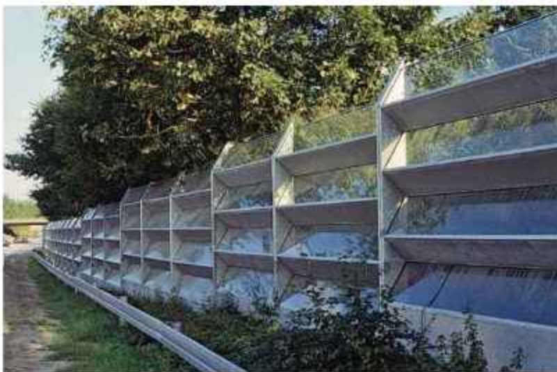
Слика 3.26. Пример комбинације апсорпционог и транспарентног зида [24]
