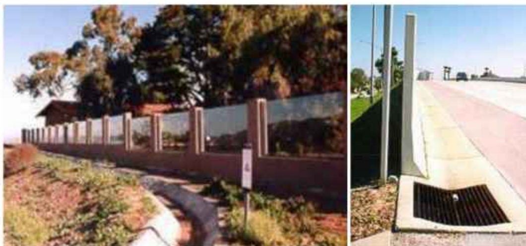
Слика 3.57 Одвођење воде поред баријере [25]
