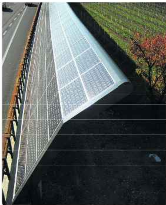
Слика 3.27. Пример баријере са соларним панелима [49]
