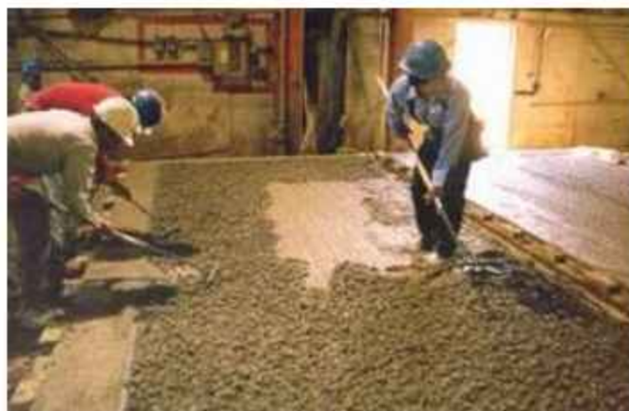
Слика 3.83. Завршна обрада бетонске баријере грабуљањем [25]
