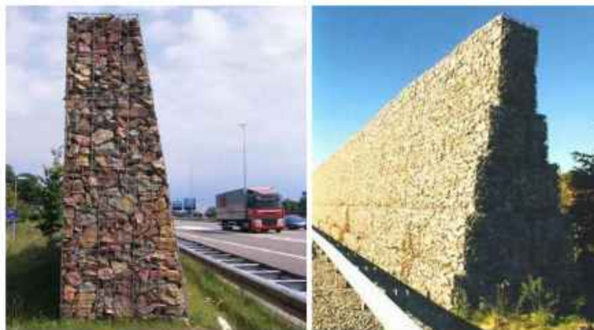
Слика 3.14. Примери габионских баријера [25], [43]
